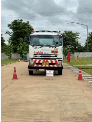
รูปที่ 2-50 การกำหนดเขตและปิดกั้นรอบพื้นที่ปฏิบัติงาน บริเวณถังเก็บก๊าซปิโตรเลียมเหลว
